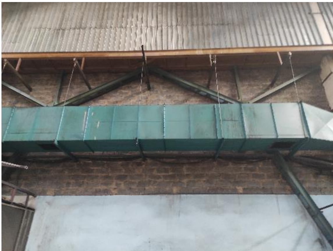
Foto. – stan istniejący ściana oddzielenia pożarowego w osi 10
